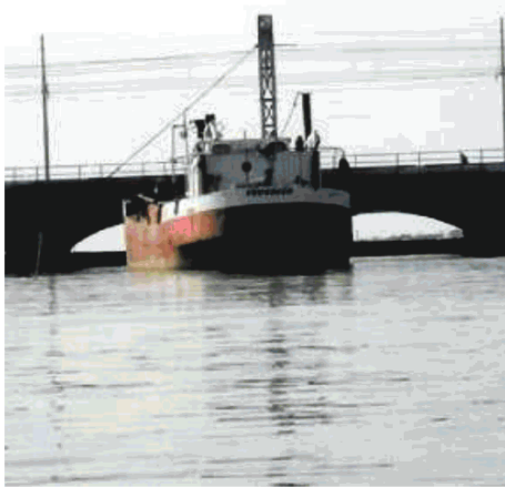
LO SCAVO La draga all'opera a metà del ponte della Libertà
